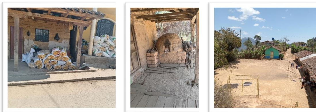
Figura 32. Viviendas en la parroquia Cangonamá
